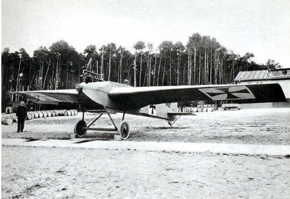
Fuselaje sin recubrimiento de un Fokker DVII, fuselaje en tubo de acero y ala en madera, recubrimiento de tela y Junkers J1, de fuselaje metálico corrugado.
